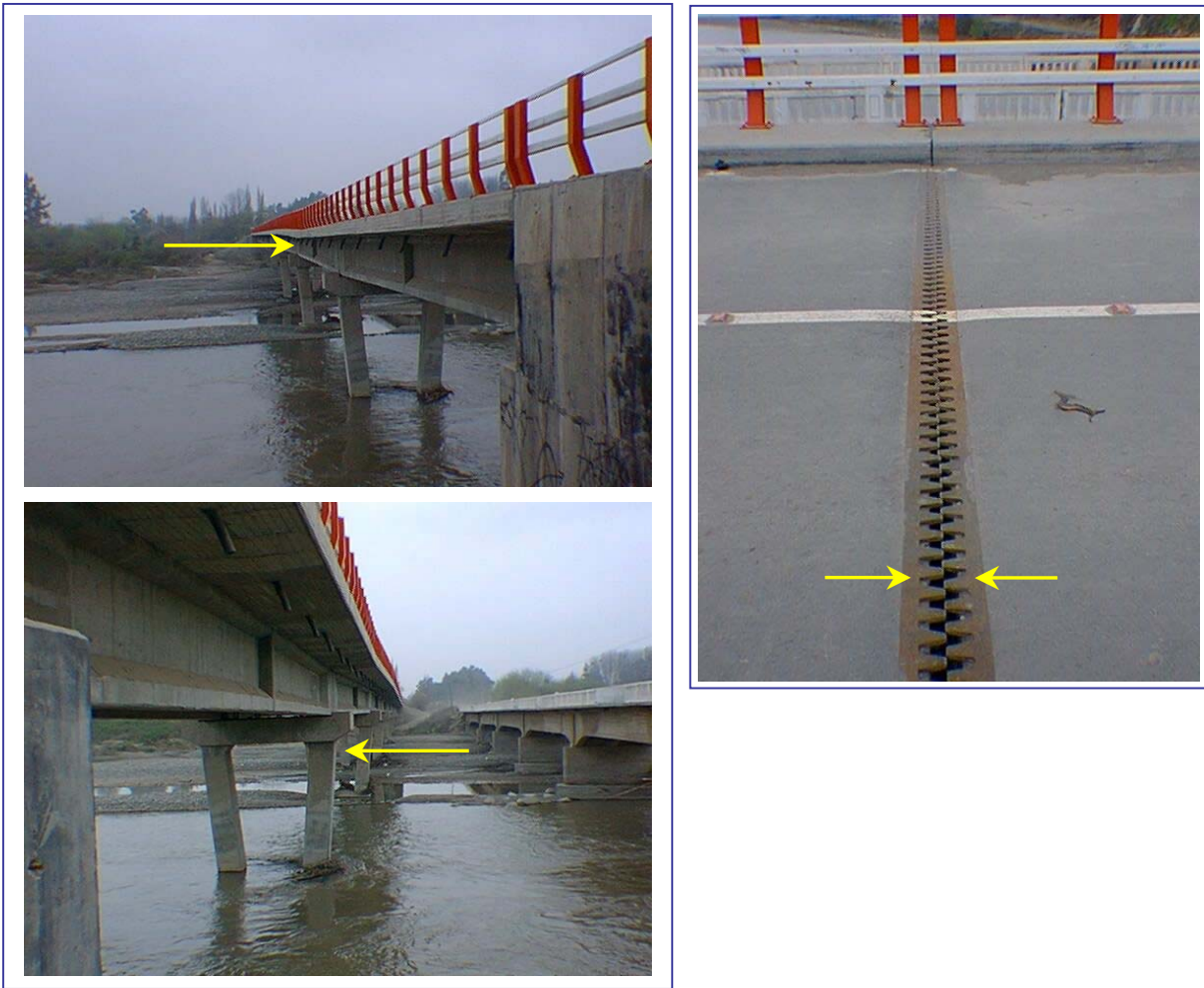
Foto N° 2 Falla de la pila N° 1, Puente Nuevo de Naltahua, Crecida de Junio 2002
